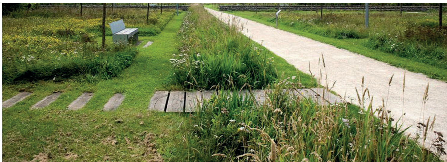
Bassin de rétention à ciel ouvert
